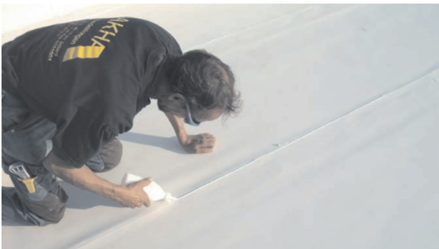
Aanbrengen van vloeibare folie.
