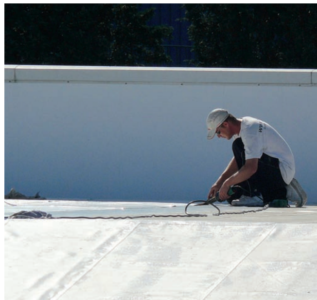
Alle overlopen zijn handmatig gelast.
